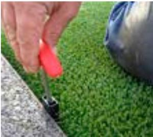
Das Befestigungselement wird mittels Einbauschlüssel in das Einbauelement, bis zum unteren Steg, eingefügt (beachten Sie die Bilder auf den vorangehenden Seiten).
