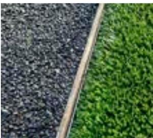
Belag / Kunstrasen (Zwecks Erhöhung der Belagsfläche wurde hier ein Metallband (Flachstahl) eingesetzt.)
