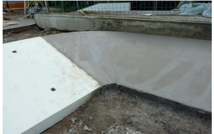
Kombination aus Ortbeton und Fertigteilen
